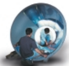
Proyecto Artelio Conducto D=90 cm, L=14 m
